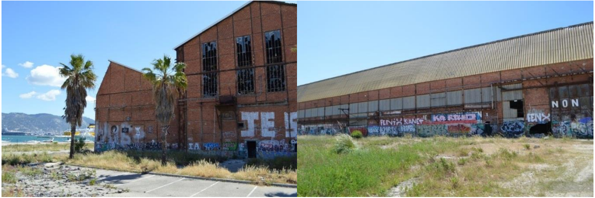
Fig. 4 y 5. El taller de mecánica y calderería en 2017, poco antes del inicio de su demolición. Al fondo (fig. 4) el puerto y la ciudad de Toulon.
