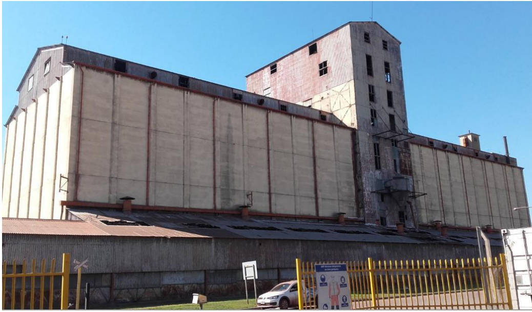
Figura 7: El silo elevador “Rosario Centro” en 2017.
