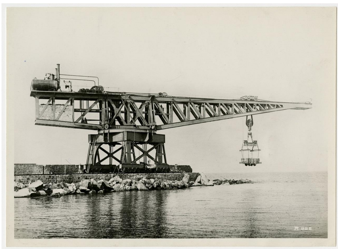
Imagen 3. Grúa titán de 110 toneladas construida por Fives-Lille (Francia) y utilizada para construir el puerto de Djidjelli (Argelia), fotografía en blanco y negro, s.d.
