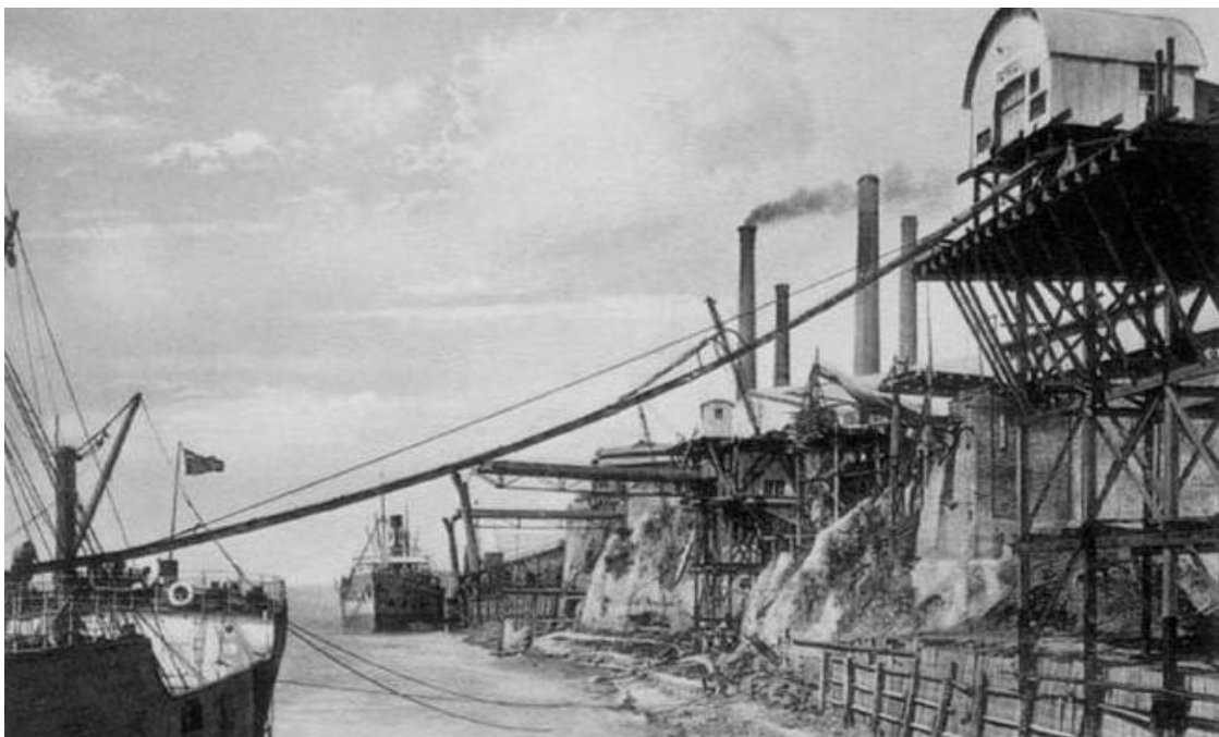
Figura 4: Carga de barcos por el sistema de “canaletas”.
